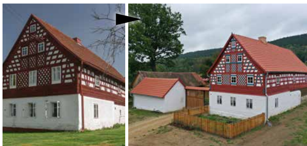
Milíkov (Karlovarský kraj) Rekonstrukce chebského statku
