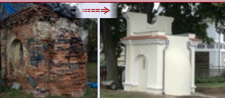
Ohníč (Ústecký kraj) Oprava kapličky u Starého mlýna v Dolánkách
